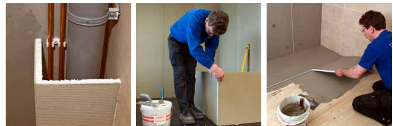
Multiplaat om bijvoorbeeld leidingen weg te werken, bad-ombouwen te maken of vloeren en wanden tegelklaar te maken.
